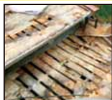
②雨水が屋根の下地に侵入、構造物(木材)が腐朽
